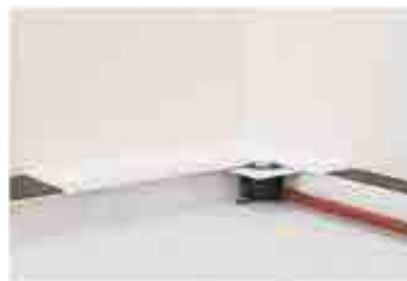
18. Разрез пола с установленным плоским душевым поддоном и сифоном
