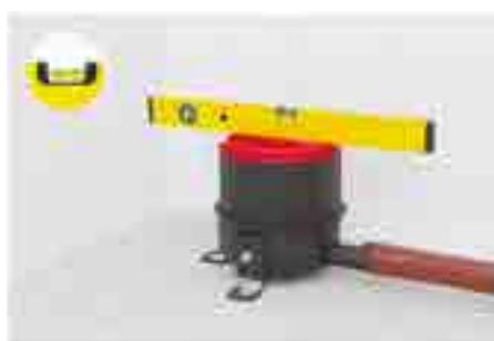
6. Установить корпус на заданную высоту, обеспечив нужный уклон отводящего трубопровода.
